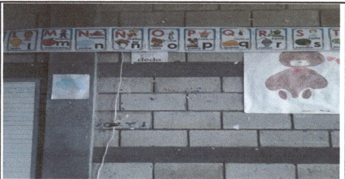
Foto 5: Pintura en muros exteriores e interiores en aulas.
