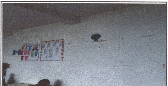
Foto 6: Pintura en muros exteriores e interiores en aulas.
