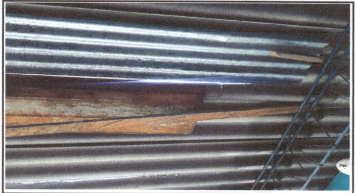
Foto 2: Cambio de techo por lamina Aluzinc calibre 26, en cocina
